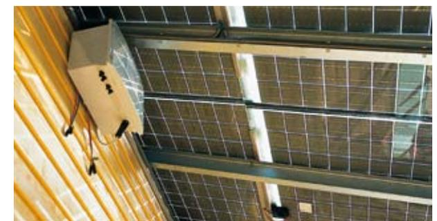
Untersicht Photovoltaikdach mit Wechselrichter
