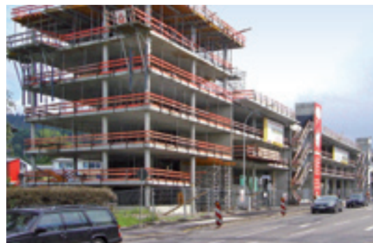
Rohbau des Sonnenschiffs Mitte 2003
