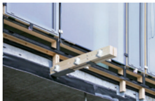
Detail der Holz-Pfosten-Riegel-Fassade
