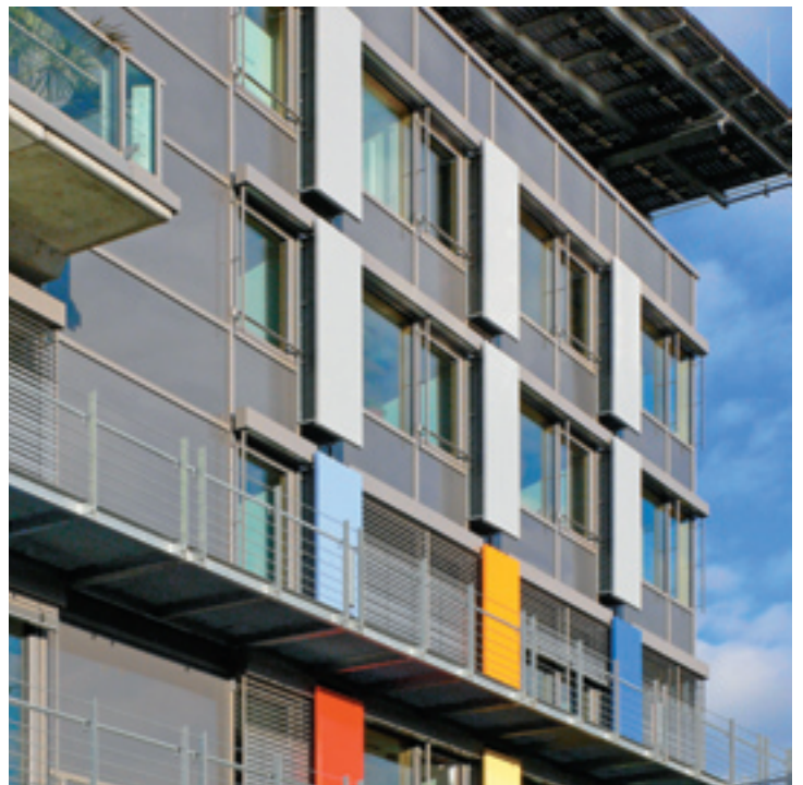
Außenwand aus Vakuumisulationspaneelen
